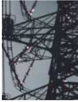
(写真1) 激しく放電する鉄塔の「がいし」
